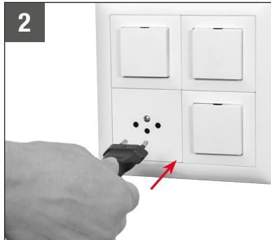
Zapojte vidlici napájecího kabelu do síťové zásuvky.
